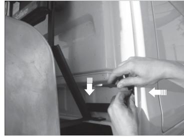
Posicione o suporte e coloque os parafusos com as arruelas.
